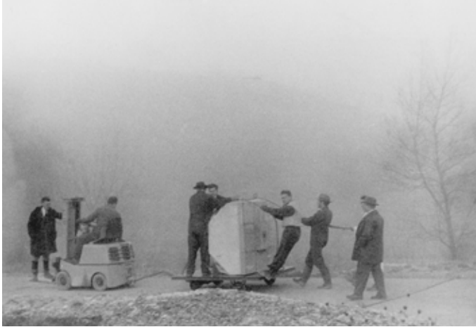
↑ Transport de l'édifice expérimental vers la dalle d'essai à Moronvilliers en 1959
